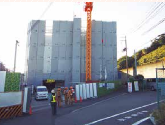
▲着工から6ヵ月経過
